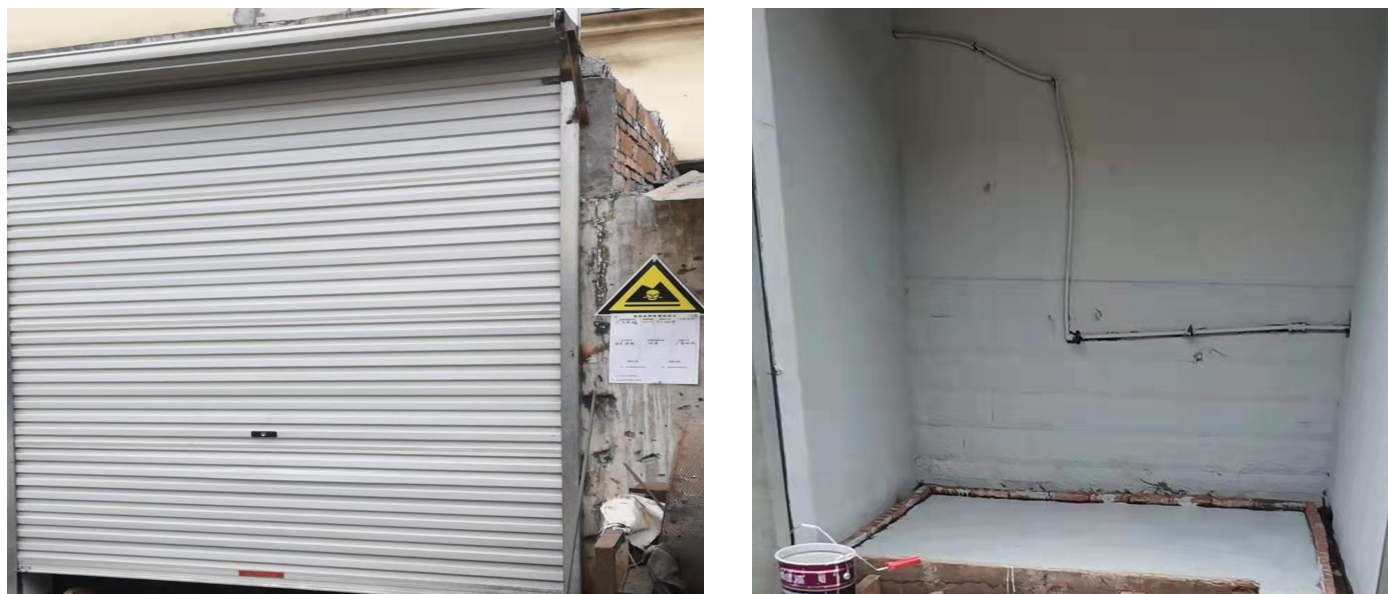
图 3-5 危废仓库内外景现场图
