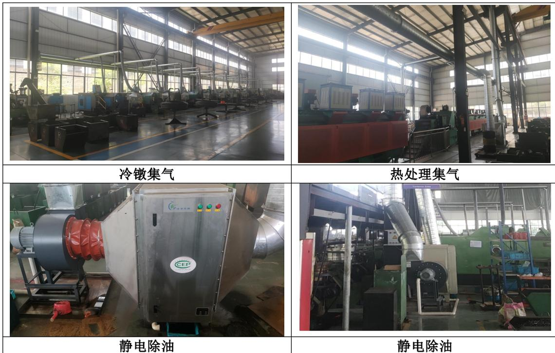
图 5-1 废气产污节点和处理设施现场图
