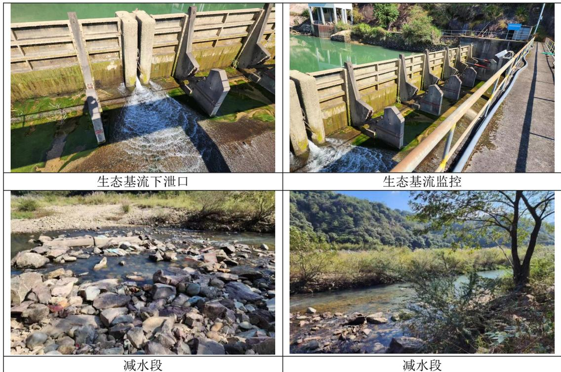
图 4.2-1 生态流量下泄设施和减水河段
