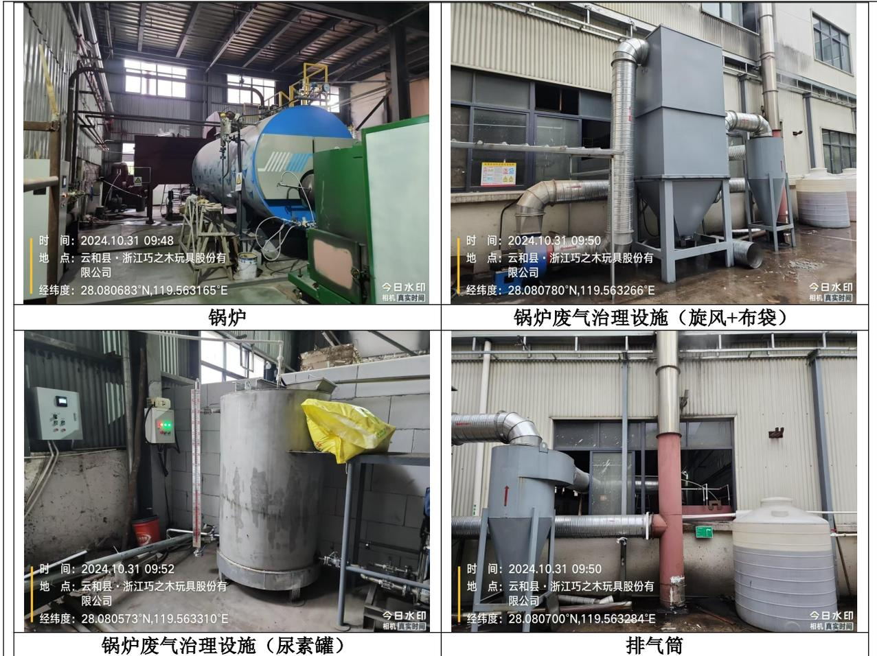
图 3-2 废气产污结点和处理设施现场图
